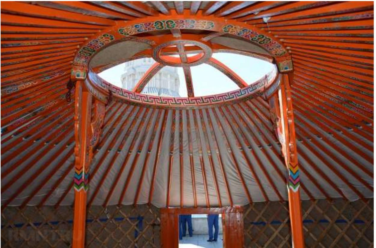
В ободке необходимо пропиливать сквозные отверстия для того, чтобы вставить стропила. К решётке стен кровельные балки юрты традиционно крепятся верёвками в местах крестовин — соединений планок. Между собой отдельные секции решётки тоже присоединяются ремнями или верёвками. По всему диаметру стен юрты также целесообразно протянуть шнур, ремень, канат, чтобы сделать конструкцию ещё более надёжной.
