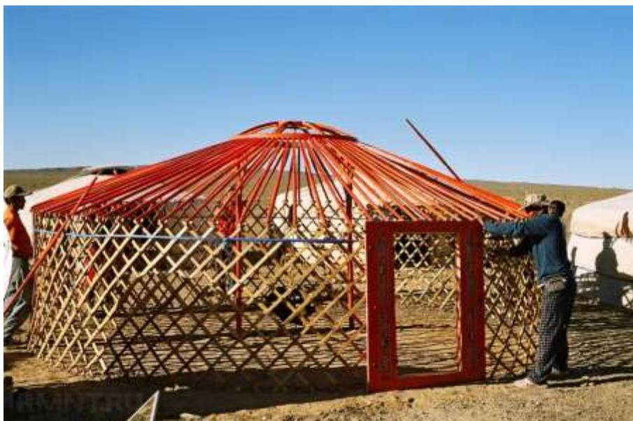
Если юрта будет действительно переносной, разборной, очень важно, чтобы решётка из реек собиралась гармошкой! Поэтому саморезы для скрепления реек не подойдут — получите просто стационарную решётку для беседки.
