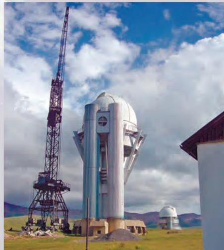
Обсерватория Ассы-Тургень. На переднем плане – недостроенная башня для 1,5-метрового телескопа. На заднем плане – работающая башня 1-метрового телескопа. Алматинская область, лето 2011 года.
